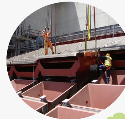
Fabrication de grilles et poussoirs pour le système de combustion des déchets dans les centrales d'incinération
